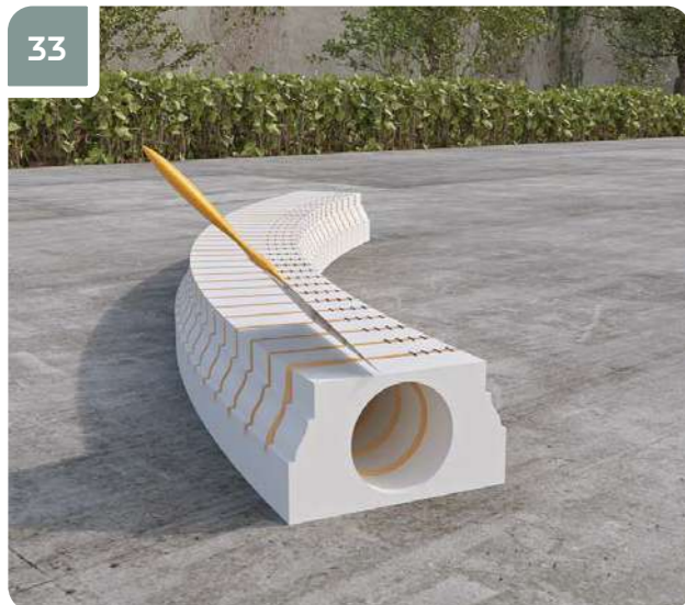
33 Удалить выступившие излишки клея шпателем.
